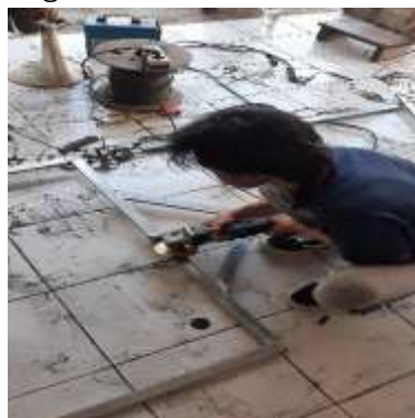
Gambar 11. Proses pengamplasan
