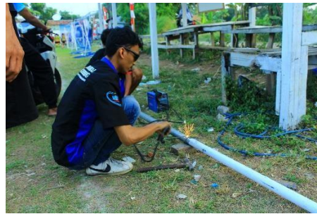
(2) Proses Pengelasan Tiang PJU
