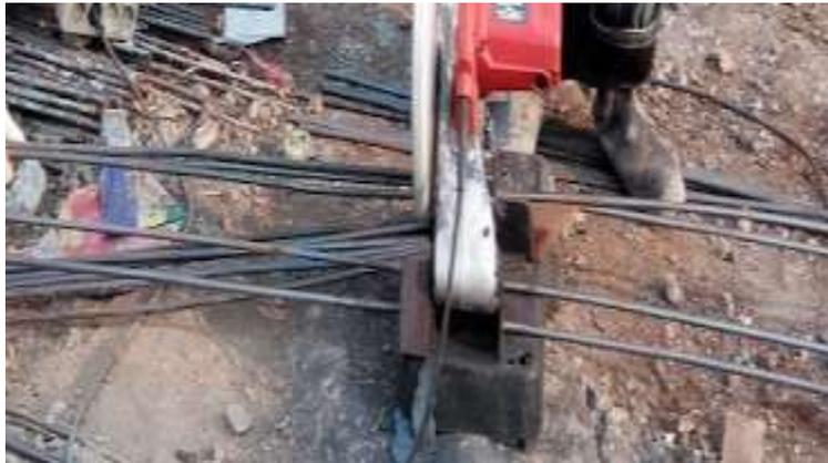
**Gambar 4.** Proses Pemotongan Besi
