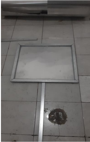
Gambar 2. Pembuatan frame besi
