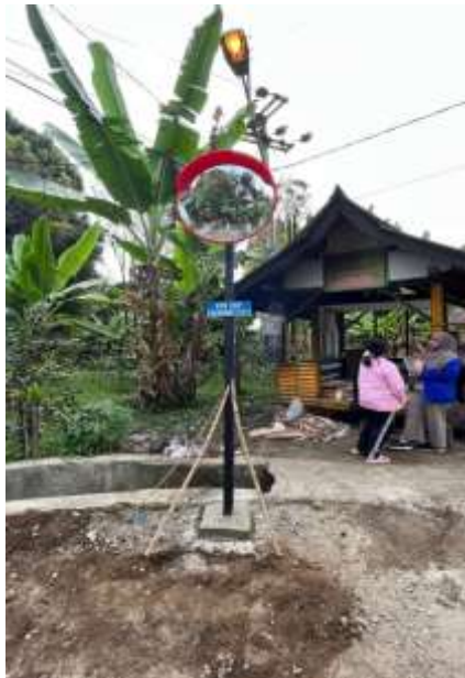
Gambar 5 Pemasangan Kaca Cembung Pada Titik 1
