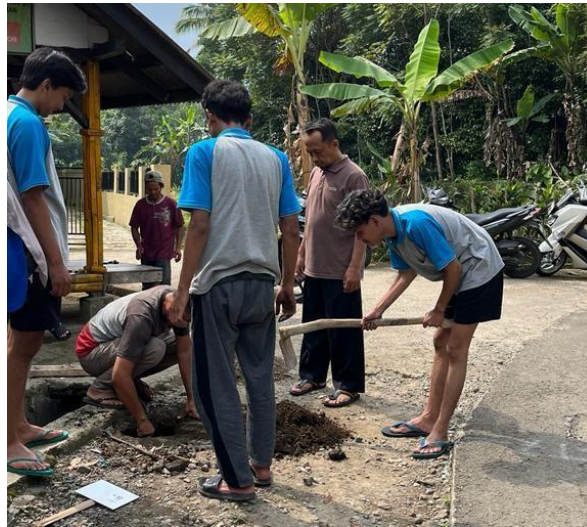
Gambar 1. 3 Proses Penggalian Untuk Tiang Convex Mirror
